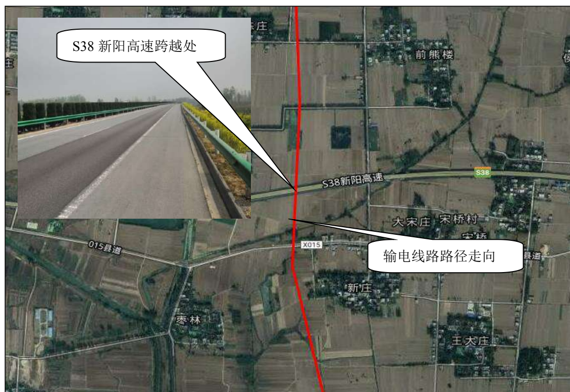
图 2 跨越信阳高速位置及现场图片
